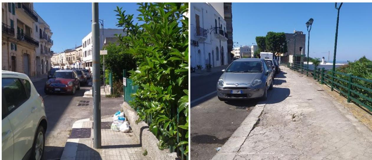
Figura 26 - Corso Vittorio Emanuele: a sinistra il dettaglio del palo della luce che divide la sezione del marciapiede; a destra il dettaglio del pavimento divelto.
