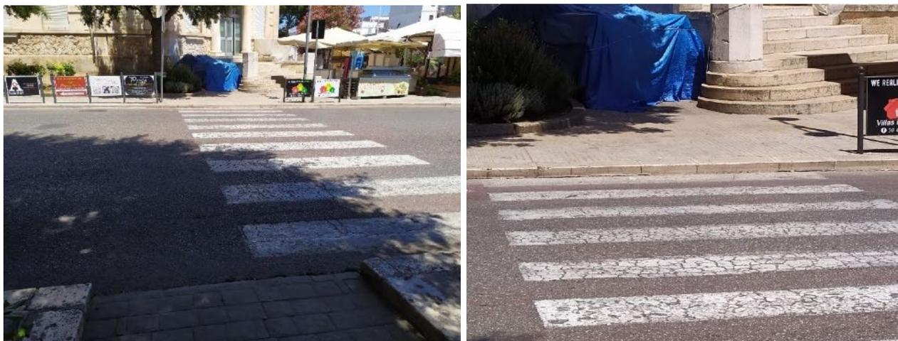
Figura 27 - Viale Pola: mancanza di scivolo su un lato dell'attraversamento pedonale
