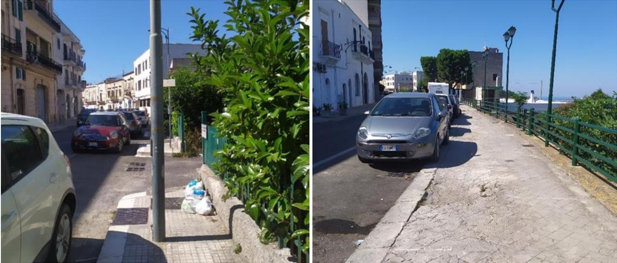
Figura 131 - Corso Vittorio Emanuele: a sinistra il dettaglio del palo della luce che divide la sezione del marciapiede; a destra il dettaglio del pavimento divelto.
