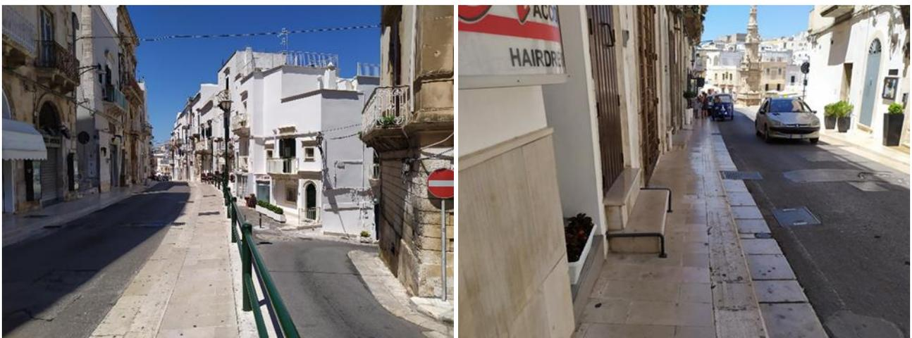
Figura 130 - Corso Garibaldi: a sinistra una foto della sezione stradale; a destra una foto del gradino sul marciapiede che rappresenta una barriera architettonica.
