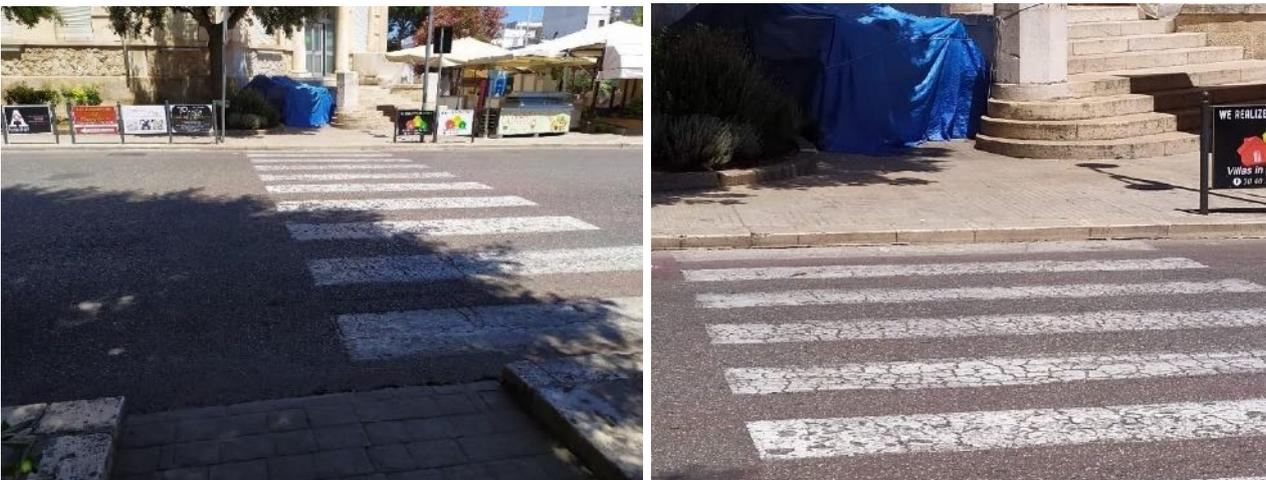
Figura 132 - Viale Pola: mancanza di scivolo su un lato dell'attraversamento pedonale.
